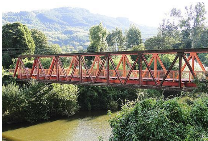
Imagen 7: Registro fotográfico Puente Collilelfu
