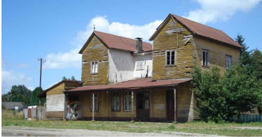
Imagen 6: Registro fotográfico de la Estación Ferroviaria Collilelfu previa a su restauración
